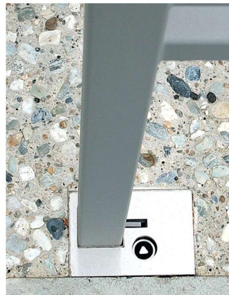
Barri res tout acier. Montants verticaux et main courante en tube de 40 x 40, lices horizontales en tube 30 x 30 mm. Syst me amovible inox, 106 x 80 x 205 mm. A sceller profondeur 205 mm. Pr voir une couche drainante en fond de r servation pour l' coulement des eaux.
