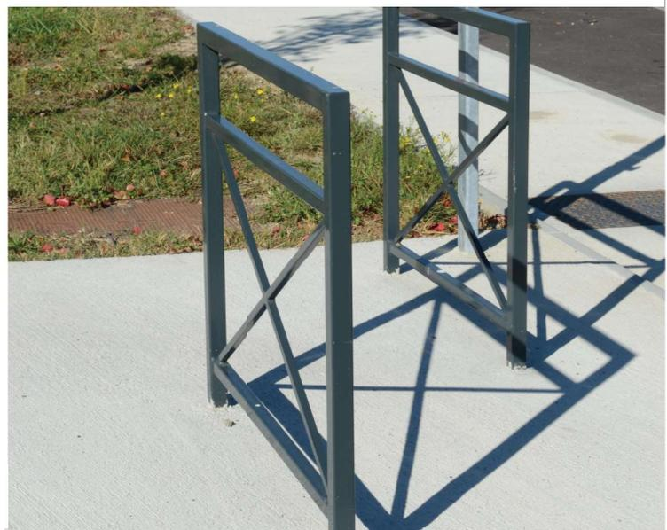
Barri res tout acier. Montants verticaux et main courante en tube de 40 x 40, lices horizontales en tube 30 x 30, croisillon int rieur en carr  16 x 16 mm.
